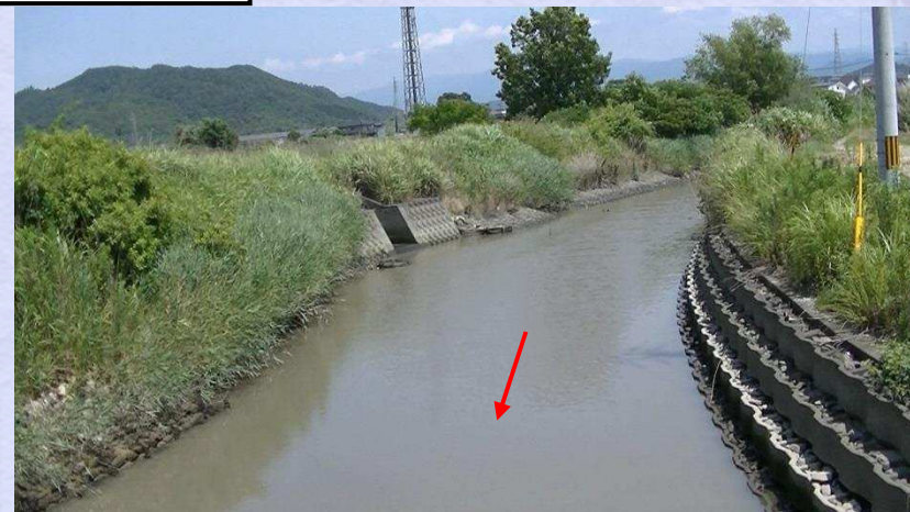
馬之瀬樋門より上流を望む
