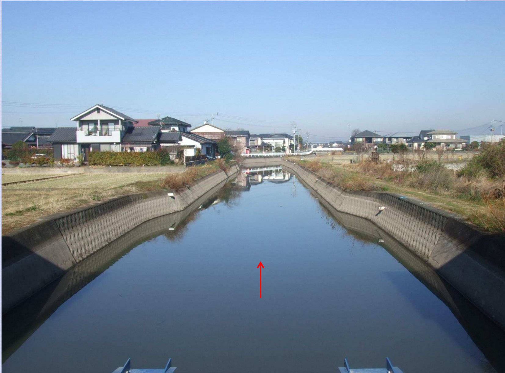
① 本事業において整備された最上流部の護岸(松原町)
