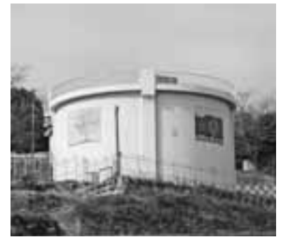
▲宇土市配水池
