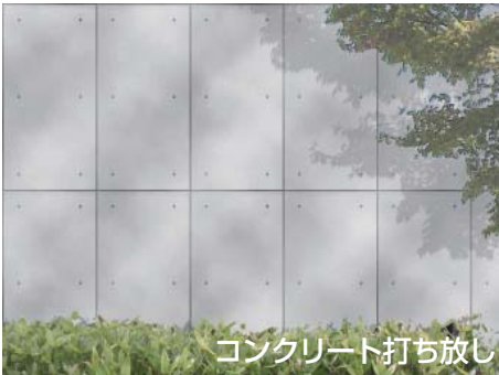
杉板型枠コンクリート打ち放し
