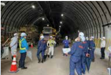
笹原トンネル内部の様子
