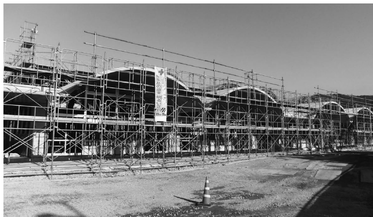
建設中の網津小学校
