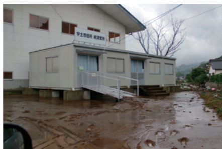
15 網津支所仮庁舎
