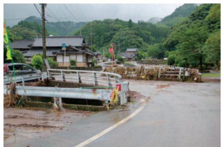
河川氾濫(網津川)
