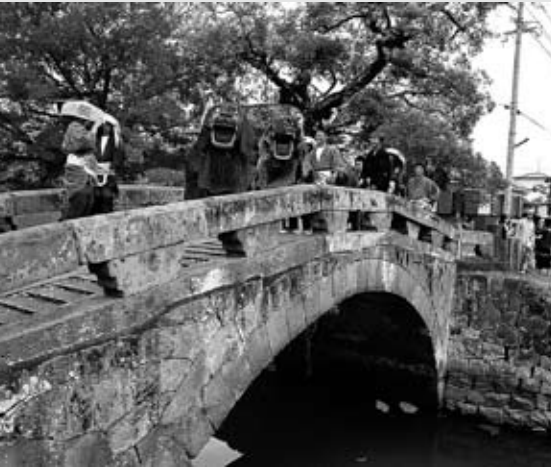
熊本地震被災前の船場橋
