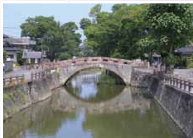
船場橋（めがね橋） 文久元年に架橋され、今なお昔の面影を残す。赤味を帯びた馬門石の輪石が特徴
