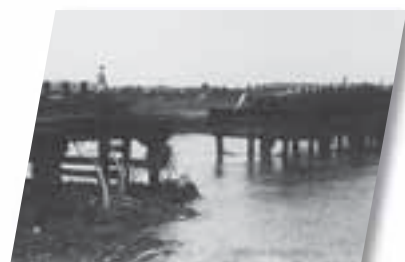
■豪雨により流失した平木橋
