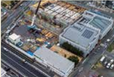
建物の工事(1階～4階) 令和4年3月～12月
