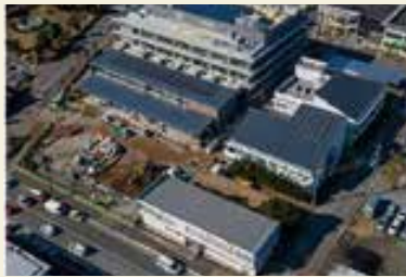
新庁舎完成 令和5年1月
