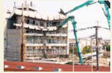
被災した庁舎の解体作業
