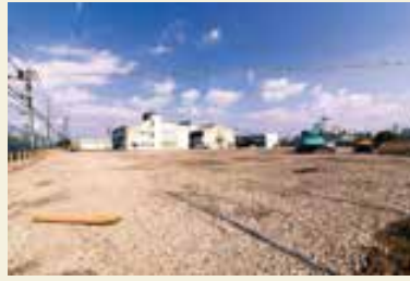
解体作業が終わり更地に
