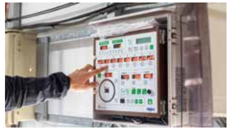
スマート農業の1つで、ハウスの温度や水分量を管理する制御パネル。
