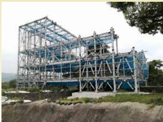
復旧工事中の熊本城宇土櫓
