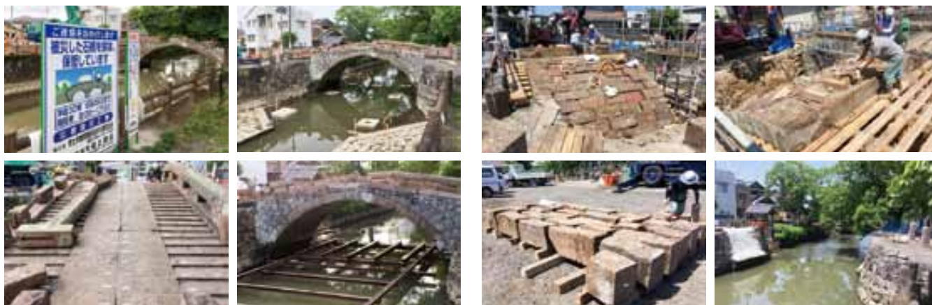
船場橋解体工事のようす
