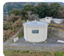
第1配水池 (轟配水池)
