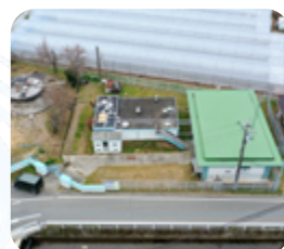
第1水源地 (宮庄水源地)
