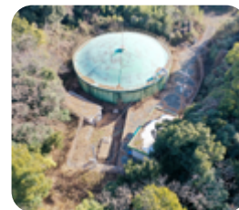
第2配水池 (花園配水池)
