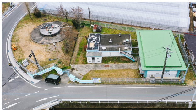
第1水源地（宮庄水源地）
