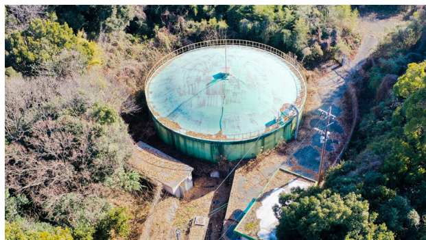
第2配水池（花園配水池）
