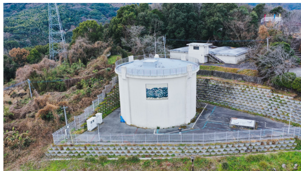
第1配水池（轟配水池）
