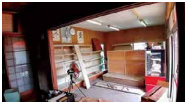
改修工事前の上田商店
