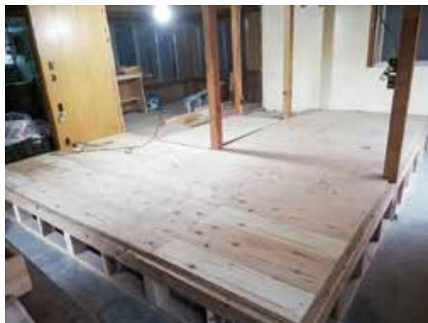
改修工事を進めています
