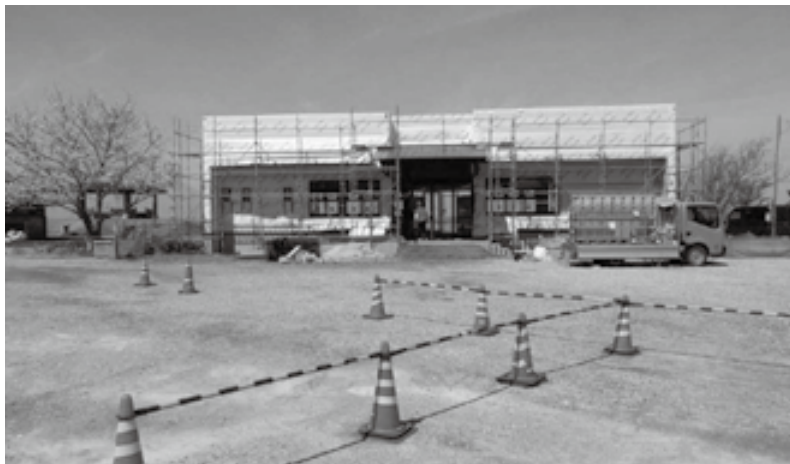
住吉海岸公園に建設中の直売所
