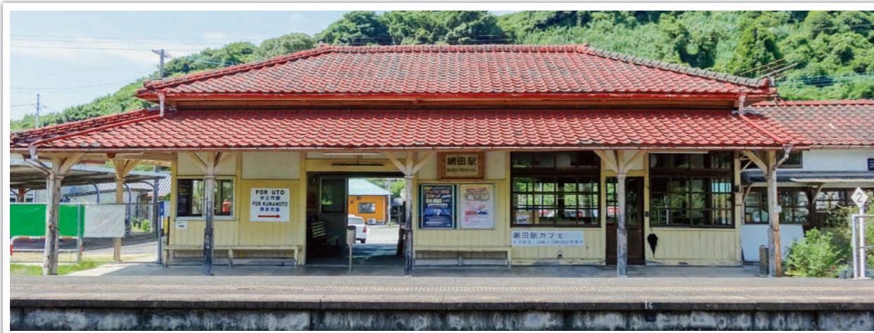
●現存する熊本県最古の駅舎「網田駅舎」国登録有形文化財登録
