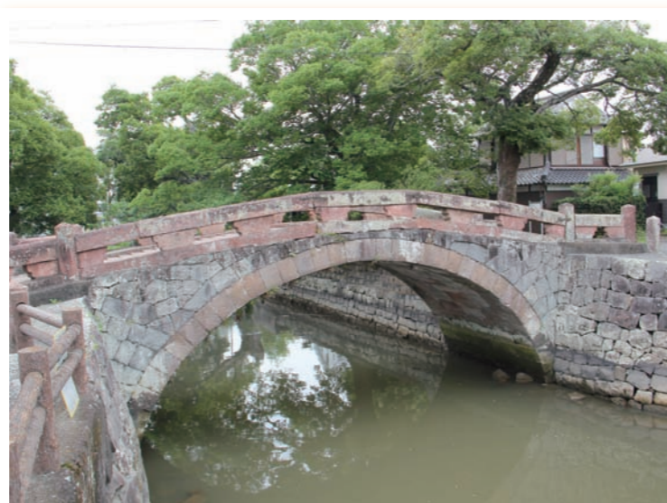
船場橋(めがね橋) 文久元年に架橋され、今なお昔の面影を残す。赤味を帯びた馬門石の輪石が特徴
