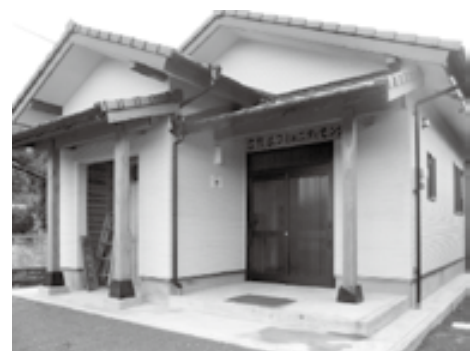
整備された岩熊区コミュニティセンター
