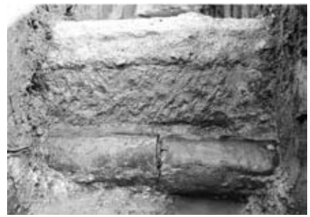
瓦質管と馬門石樋管の重複状況
