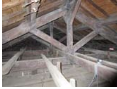
屋根裏の木組み
