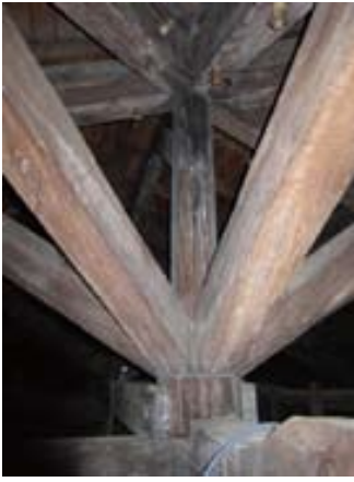
屋根裏の木組み(寄棟部)
