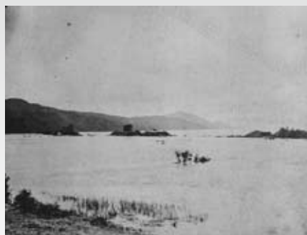
昭和2年高潮被害 決壊した網田村の潮受堤防（『昭和二年熊本県潮害誌』より）
