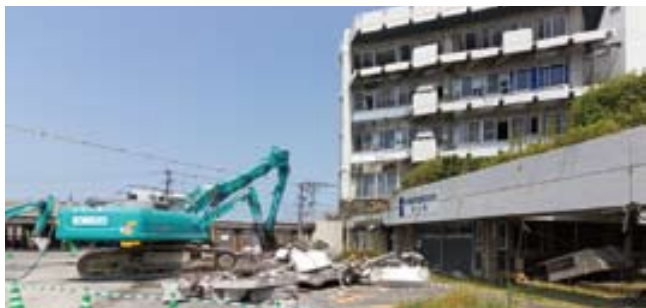
南側のひさしの撤去を終えた本庁舎
