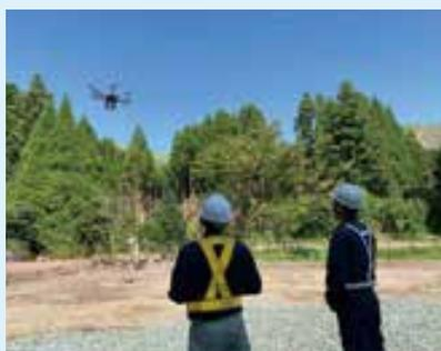
ドローン(UAV)による測量
