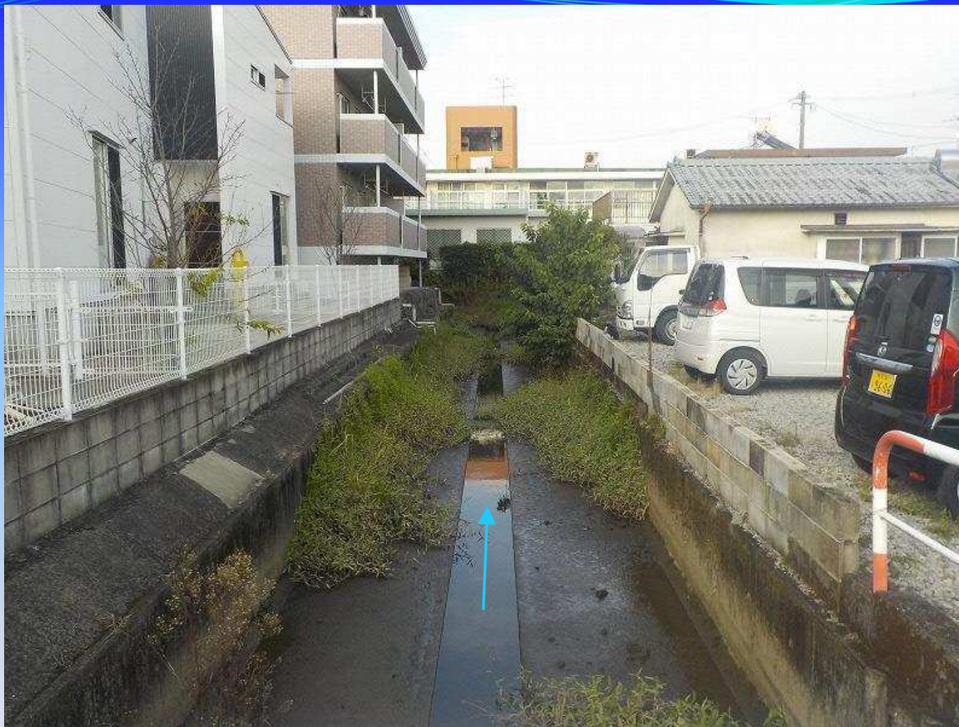
⑥ 河川の左右に住宅が建ち並び家屋移転が必要となる バイパス河川の上流部
