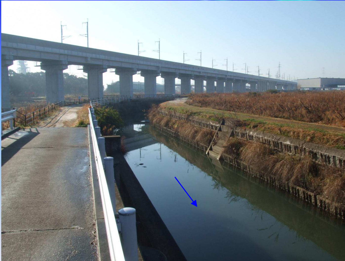
③ 環境保全型ブロックにより整備した改修済み護岸
