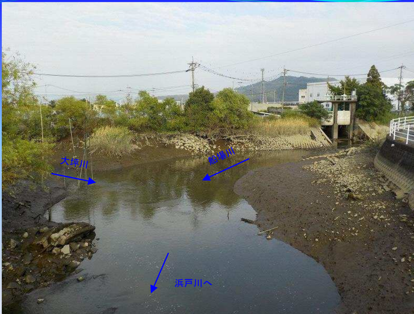
⑩ 最下流部は大坪川と合流し浜戸川へ注ぐ 船場川改修事業における最下流部
