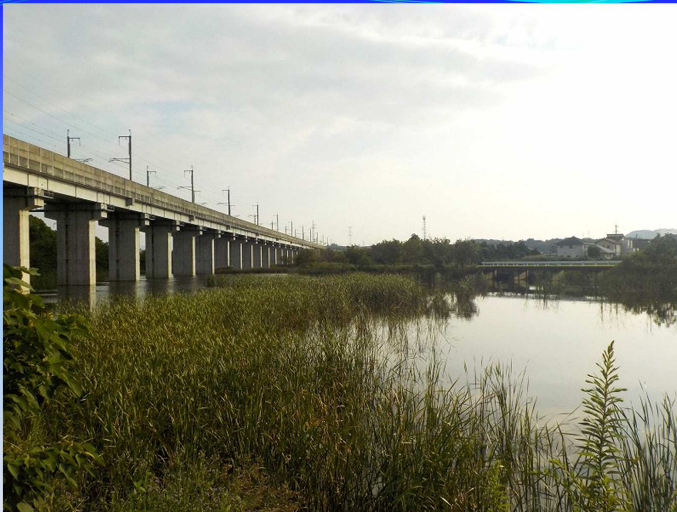
② 平成7年度から14年度にかけて整備された雨水調整池
