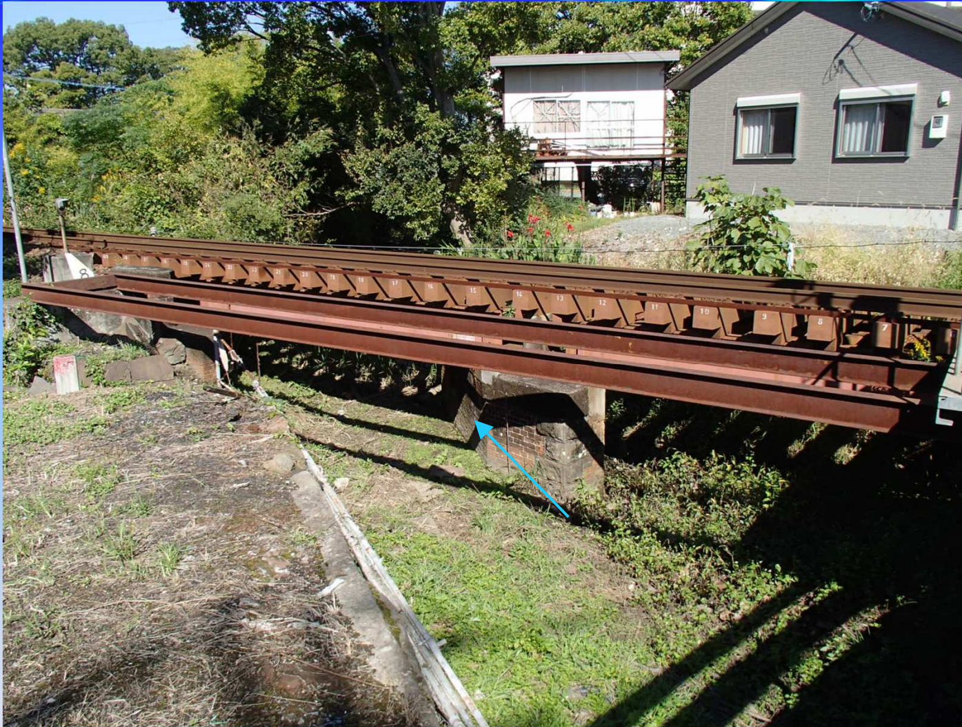
⑦ バイパス河川を横断しているJR鉄橋（2箇所）
