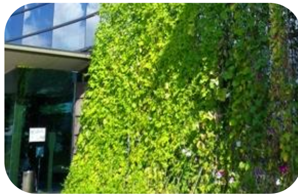
図表4-1-2 緑のカーテン（熊本市環境総合センター） （出典：熊本市）
