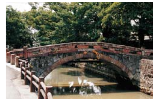
船場橋 (せんばし) 全長13.7m、幅4.1mの船場川に架かる単アーチ橋。石材は宇土市納津町で採れる馬門石と安山岩です。江戸時代終わり頃の150年くらい前に造られたとみられます。それ以前は土橋でした。付近には船着場があり、落米を運ぶための載などがありました。
