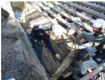
復元工事状況 (1 輪石復元作業：左岸側，2 輪石復元状況：上流側，3 輪石復元状況：右岸側，4 要石：上流側)
