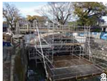
復元工事状況 (1 輪石復元作業：左岸側，2 輪石復元状況：上流側，3 輪石復元状況：右岸側，4 要石：上流側)
