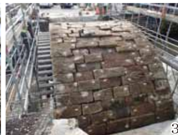
復元工事状況 (1 輪石復元作業：左岸側，2 輪石復元状況：上流側，3 輪石復元状況：右岸側，4 要石：上流側)
