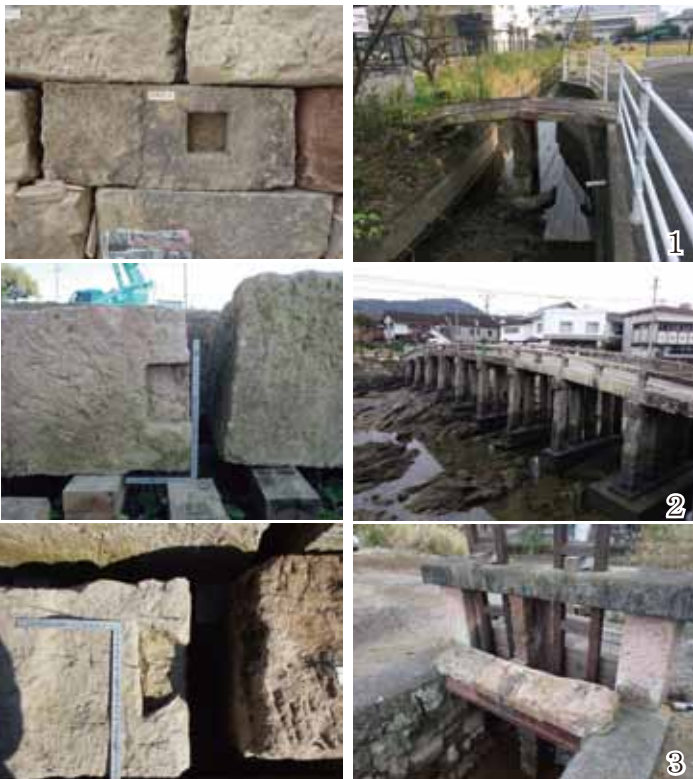
輪石転用石材（写真左列）と桁橋・樋門の例（1 御鷹野橋 / 宇土市，2 祇園橋 / 天草市，3 狐石樋 / 宇土市）
