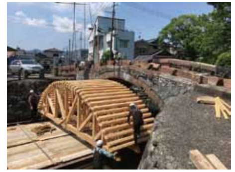
支保工設置状況
