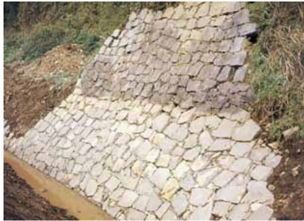
発掘調査で姿を現した近世宇土城跡本丸石垣（石垣下部の白く見える部分が土砂に埋まっていた）
