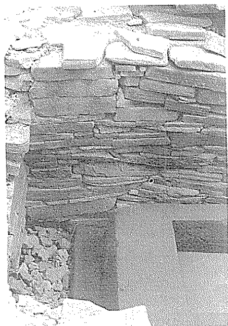
(2) 石室北東隅側壁
