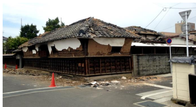
本震直後(平成 28 年 4 月撮影)
