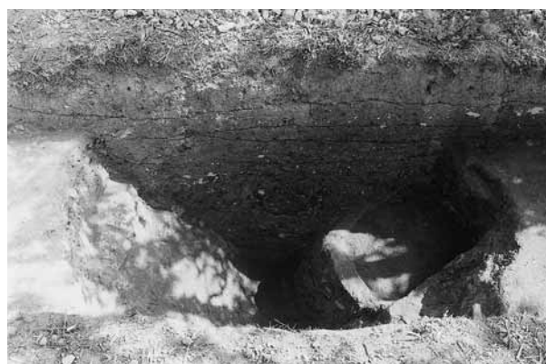
T1906溝跡 S D07土層断面 (東より)
