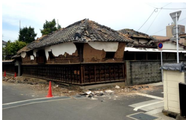
本震直後(平成 28 年4月撮影)
