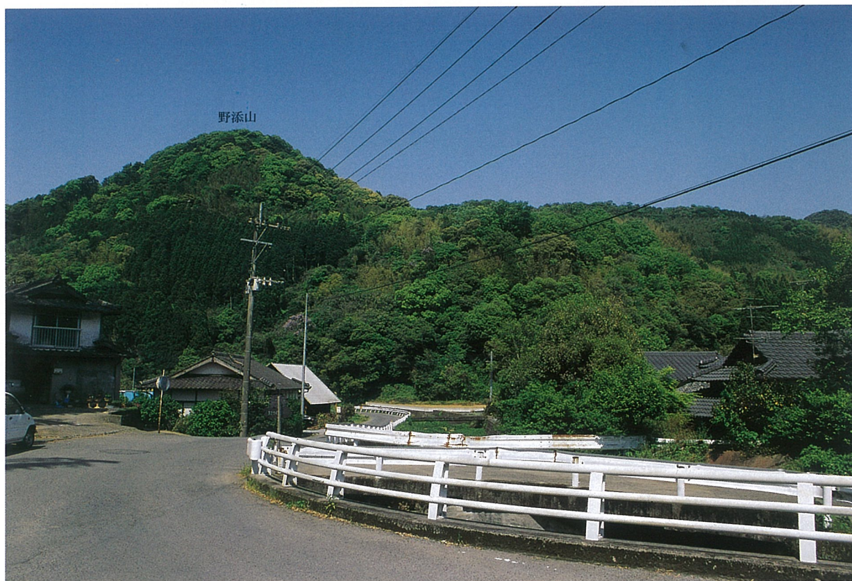
野添石切丁場跡遠景（南西より）
